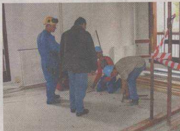
Près d'une dizaine d'ouvriers travaillent sur le chantier de la future mission locale du Haut Val-d'Oise.
